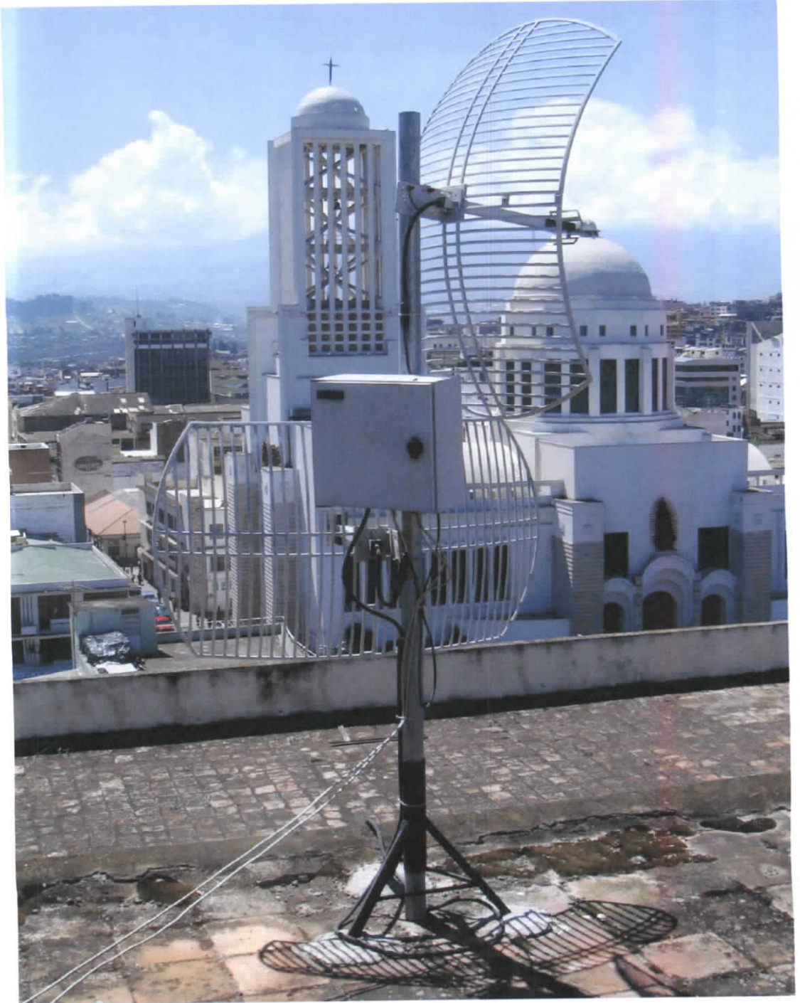
Figura 104: Antenas Spread Spectrum del H. Consejo Provincial de Tungurahua
