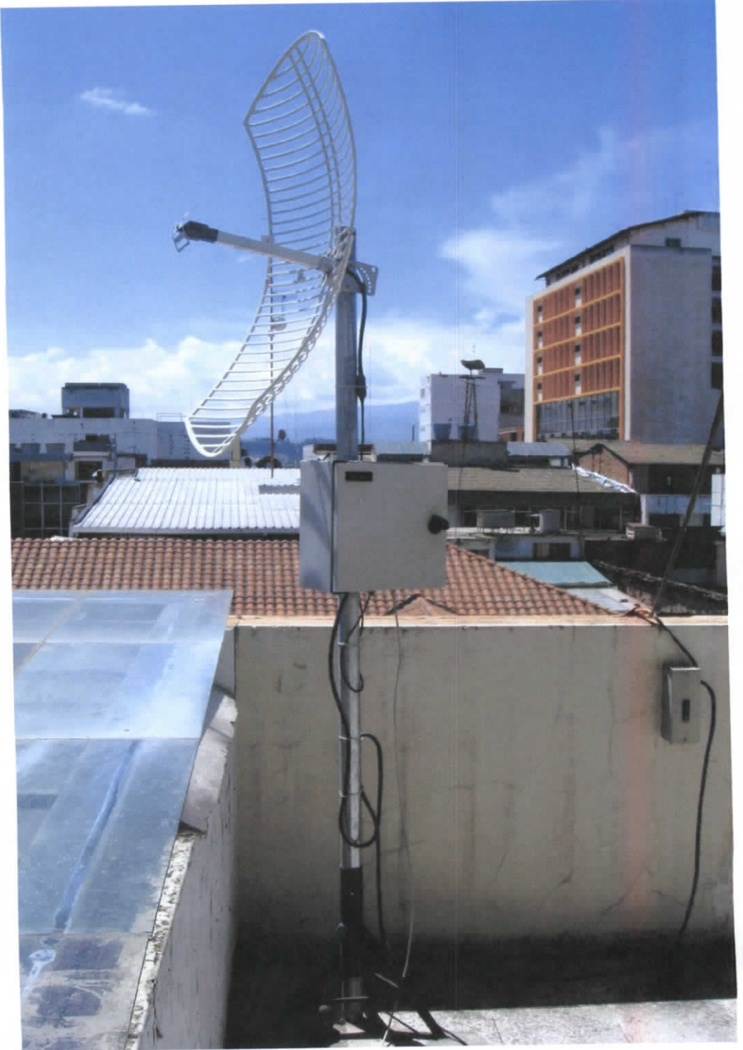
Figura 105: Antena Spread Spectrum del Gobierno Provincial
