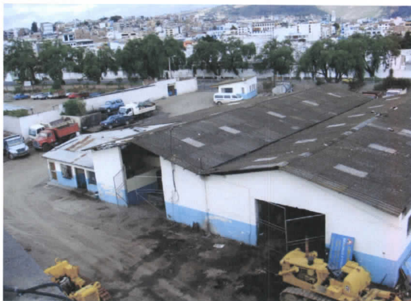
Figura 46: Área de Bodegas y Talleres del HCPT
