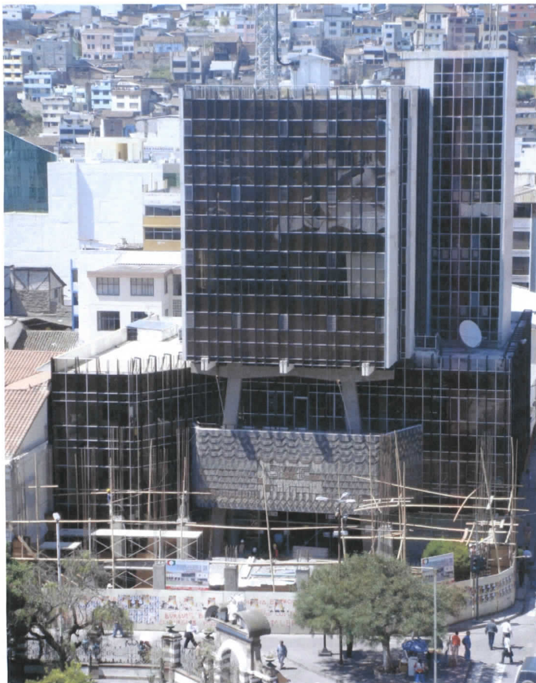
Figura 40: Edificio del Centro de Promociones y Servicio de la Provincia
