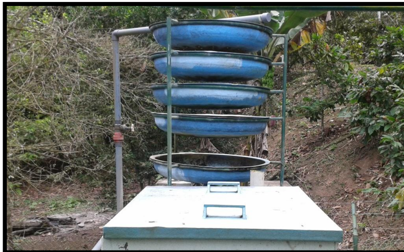
Foto4. Bandejas de aireación.
