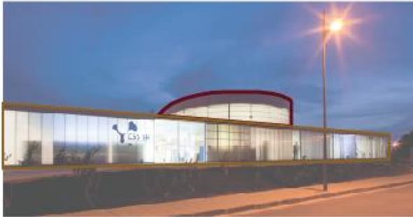
RECORRER BAJO CONSTRUCCIÓN
