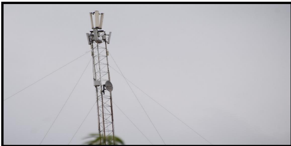
Figura 31: Torre de Comunicaciones de la UTM
