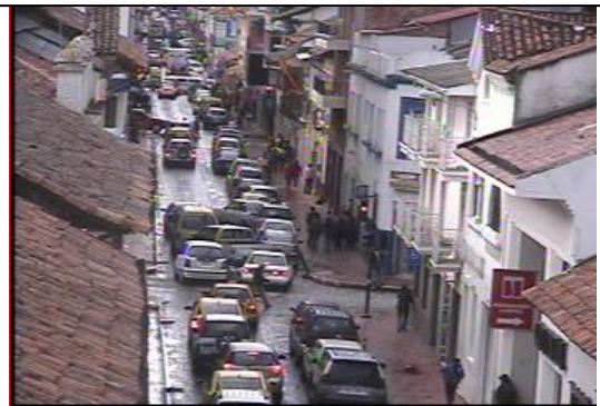
Figura 4.41: Uso de espacio público, áreas de parqueo generan demoras y congestión, Calle Hermano Miguel, sección de vía de 3,5 m libre para circulación. Parqueos con un promedio de 1 hora y media de ocupación.
