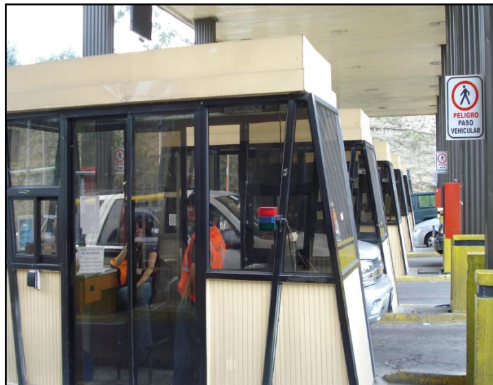
Figura 4.12. Cabinas de Peaje
