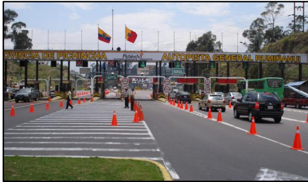
Figura 4.4. Acceso la Estación de Peaje (sentido Quito-Valle)
