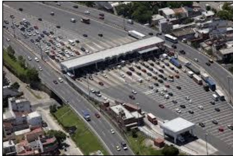
Figura 4.1. Estación Peaje (vista aérea)
