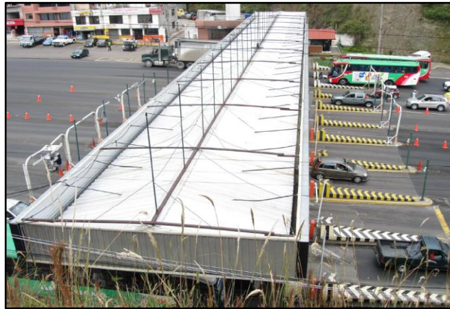
Figura 4.3. Cubierta de la Estación de Peaje
