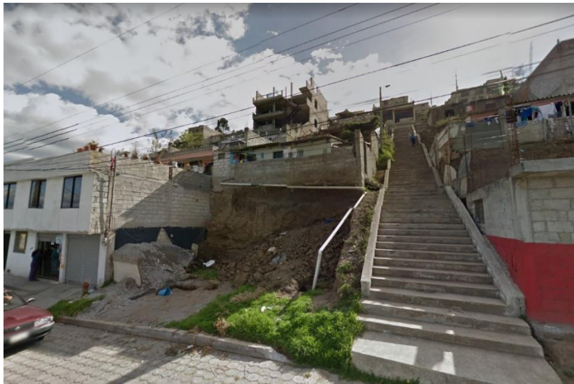
Ilustración 16 Construcción informal en pendiente (Google Earth, 2017).
