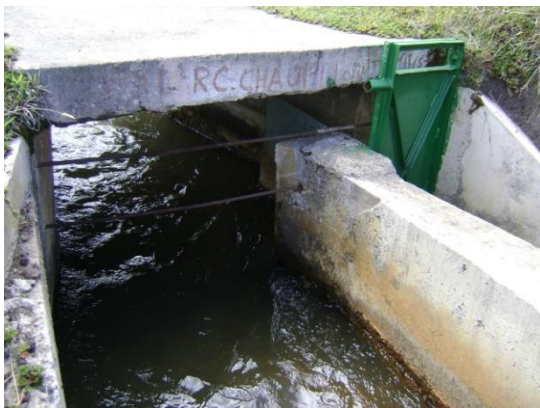
Fotografía 1. Canal de riego Porotog
