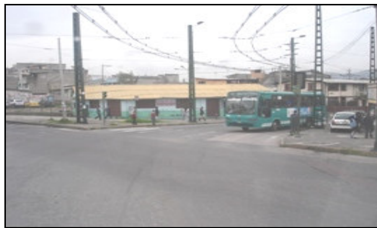
Tramo-El Calzado -Parada España Señalización Horizontal Repintar (líneas de separación)
