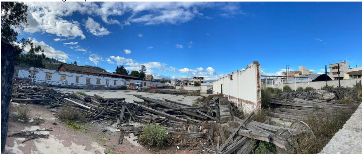
Gráfico 13. Fotografía panorámica del terreno actual
