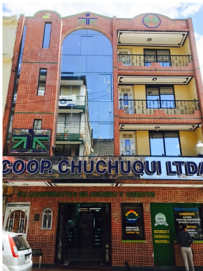
Figura 3. Fachada de la Cooperativa CHUCHUQUI
