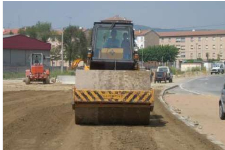
Figura II.2 Maquinaria y aplicación de Consolid
