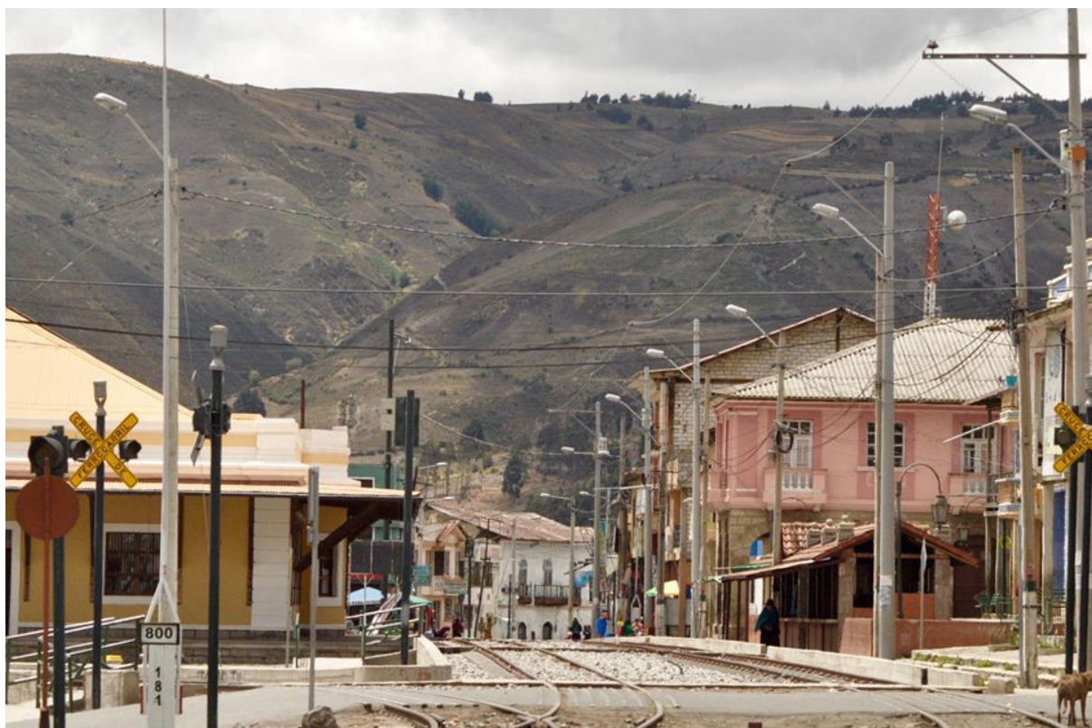
Anexo 2. Estación de ferrocarril en el Cantón Guamote
