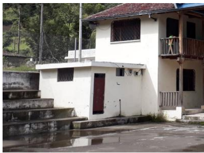
Figura 8. Baterías sanitarias de La Rinconada Elaborado por: Ander Lombeida
