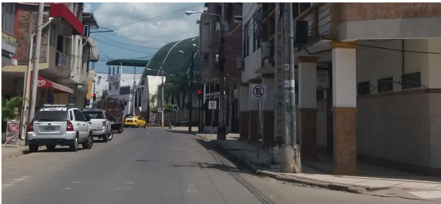
Fotografía 4. Calle Colón, antes de los trabajos de regeneración
