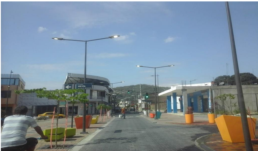
Fotografía 1. Regeneración del centro de Portoviejo. Calle Simón Bolívar y Mejía
