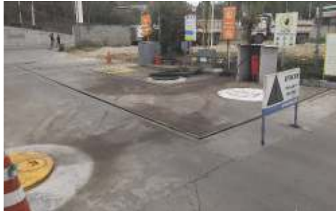
Depósito de almacenamiento de combustibles Elaborado por: Carlos Zambrano
