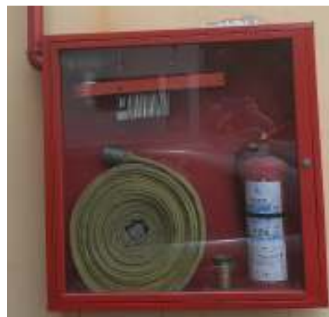
Sistemas BIE frente a los surtidores de combustible Elaborado por: Carlos Zambrano
