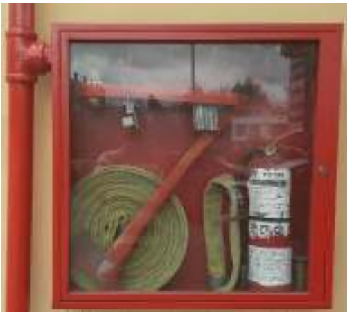
Sistemas BIE frente a los surtidores de combustible Elaborado por: Carlos Zambrano
