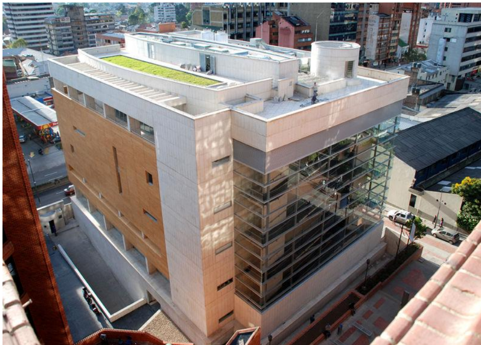
Edificio Centro Ático
