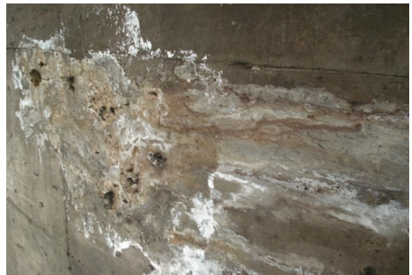
Presencia de hormigueros y eflorescencia en la losa
