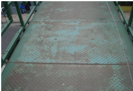
Corrosión moderada
