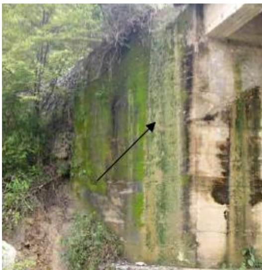
Fotografía 19: Contaminación del Concreto por Acciones Biológicas
