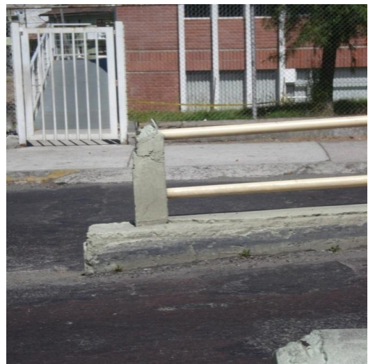
Presencia de hormigueros y eflorescencia en la losa
