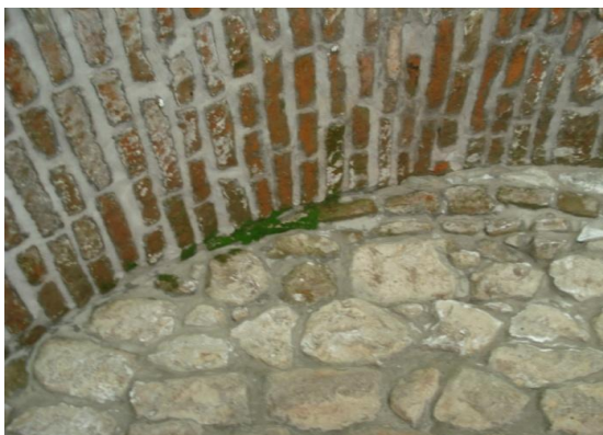
Eflorescencia en la mampostería de los arcos
