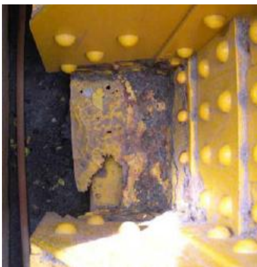
Fotografía 23: Corrosión Severa
