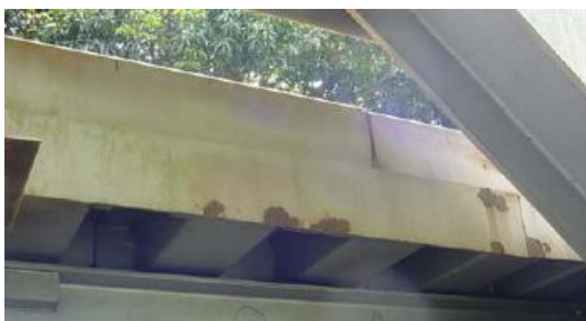
Fotografía 21: Corrosión Leve
