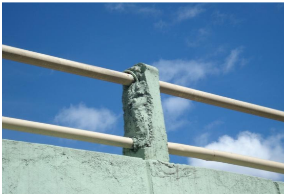
Fracturamiento en barandas
