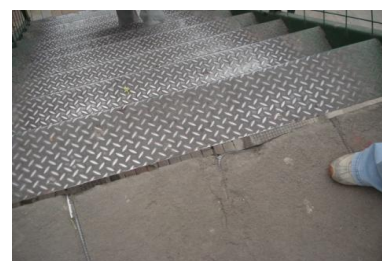
Desprendimiento de hormigón
