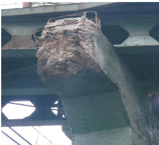
Falla producida por impacto y desprendimiento de hormigón
