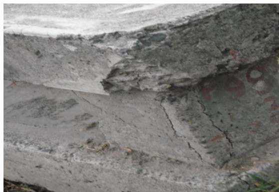
Fracturamiento en barandas
