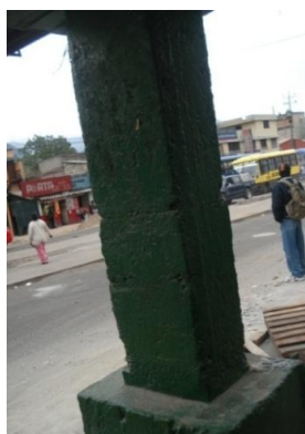
Desprendimiento de hormigón
