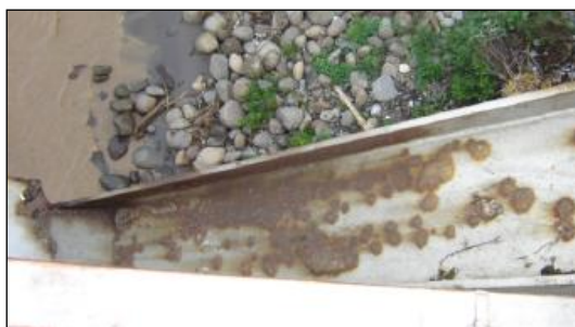
Fotografía 22: Corrosión Moderada
