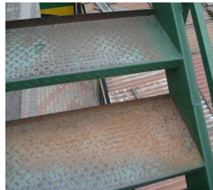
Corrosión moderada
