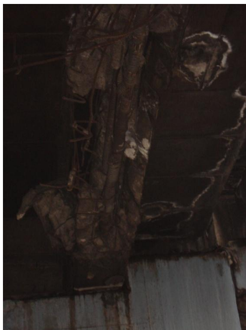
Fallas por impacto, exposición del acero de refuerzo y eflorescencia
