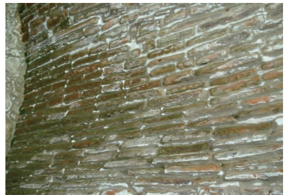
Eflorescencia en la mampostería de los arcos
