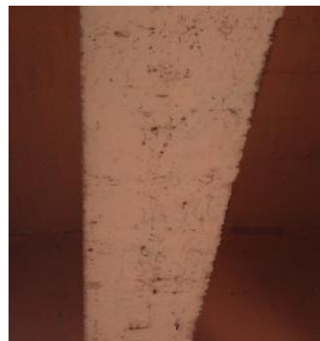
Hormigueros en las vigas longitudinales
