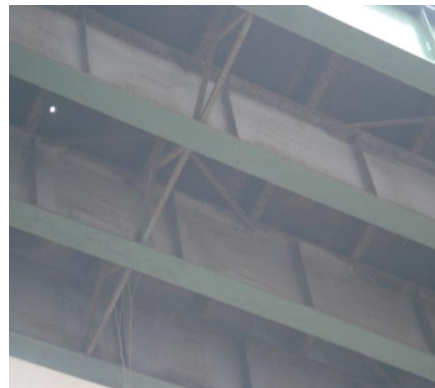
Corrosión moderada
