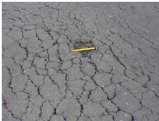
Fotografía 13: Piel de Cocodrilo en la Superficie de Rodamiento
