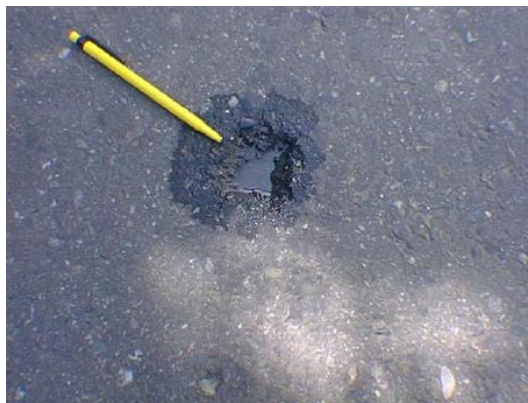
Fotografía 5: Ojo de pescado en la Superficie de Rodamiento
