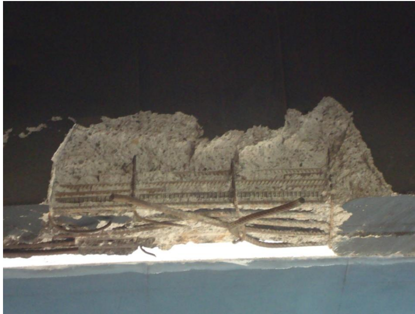
Fotografía 35: Armado de la viga exterior del puente en estudio Tomada el 13 de noviembre del 2009
