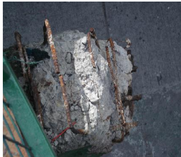
Falla producida por impacto y desprendimiento de hormigón
