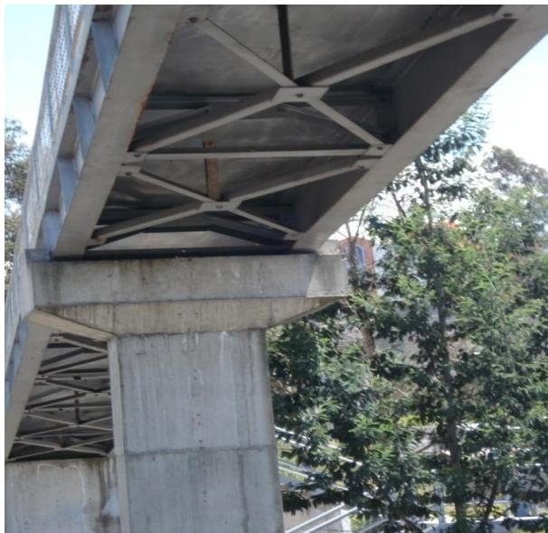
Efflorescencia, corrosión leve
