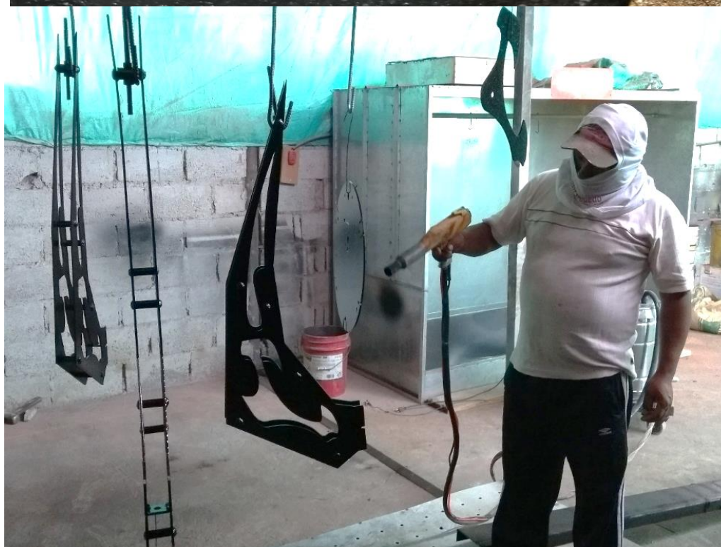
Figura 19. Proceso de pintado de piezas estructura
