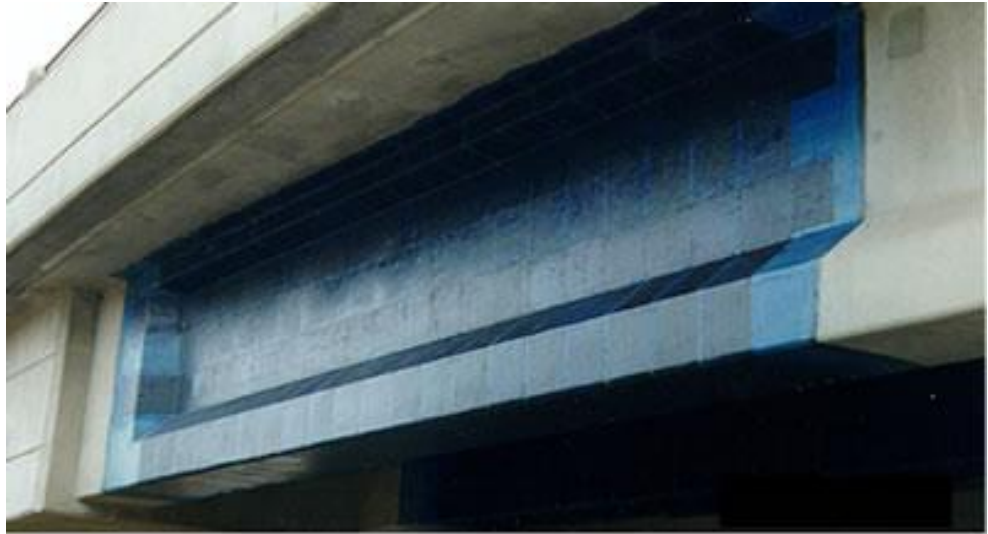
Figura 3.2.1 Viga de puente reforzada con fibras de carbono 39
