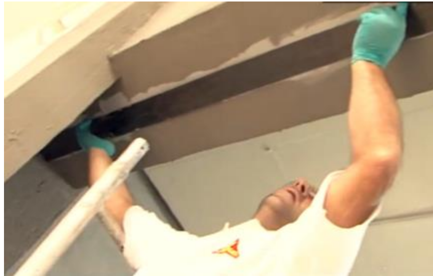
Figura 3.2.4. Aplicación del sistema FRP (Fibras de carbono) 44
