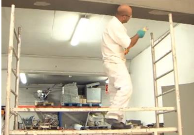
Figura3.2.3. Preparación de la superficie de hormigón 43
