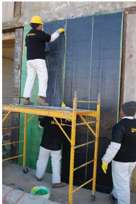
Figura 3.2.2 Muro de hormigón reforzado con fibras de carbono 40
