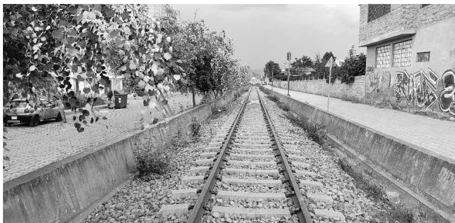
Figura 6. Eje férreo sector norte de Riobamba (foto del autor).
