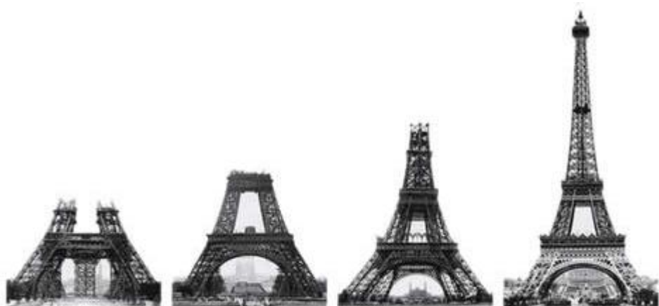
Imagen 0.3 Construcción de la Torre Eiffel 1888-1889 Fuente: http://www.urbanity.es/2005/torre-eiffel-la-francesa
