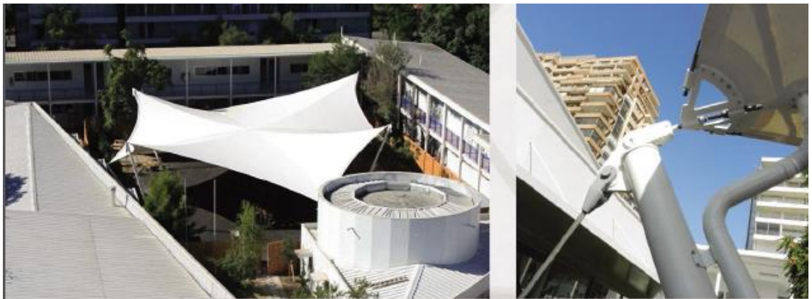
Imagen 0.5 Cubierta interna para el Colegio Leonardo da Vinci, Chile Fuente: Empresa ESPACIO CUBIERTO, portafolio de TENSO ESTRUCTURAS
