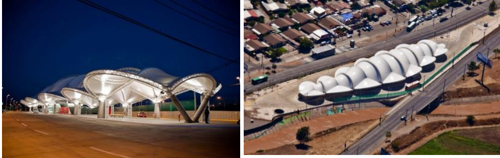
Imagen 0.26 Cubierta de la Estación de Buses EL SOL en Chile Fuente: Catálogo de estructuras de Cidelsa, empresa Chilena
