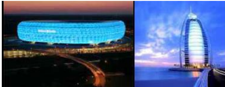
Imagen 0.8 Fachada del Allianz Arena de Munich y en el Hotel DUBAI en Emiratos Árabes Fuente: Tenso estructuras a través del tiempo
