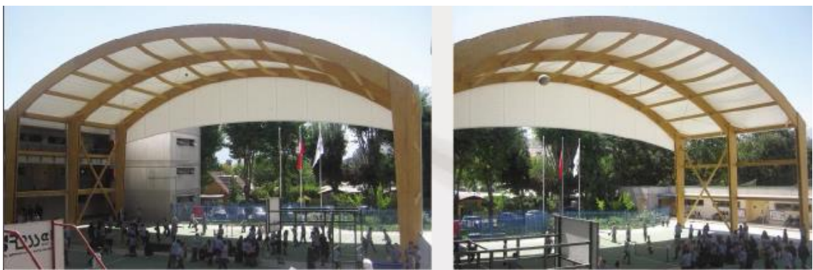
Imagen 0.3 Cubierta de Red en madera del Colegio Juan Pablo II, Chile
