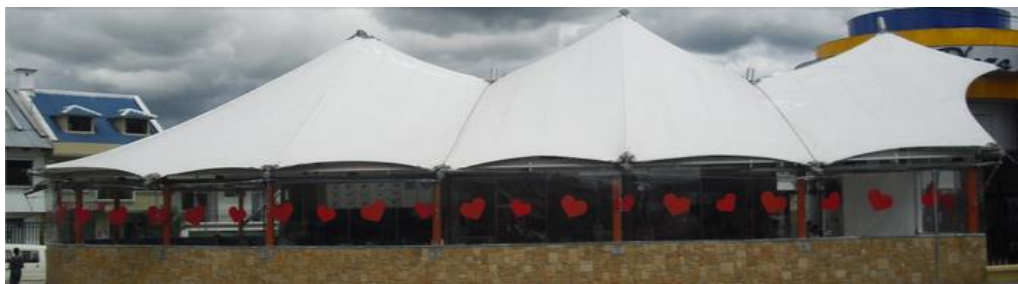
Imagen 0.30 Cubierta en Plaza Bocatti, Cuenca, Ecuador Fuente: Portafolio PREYSI
