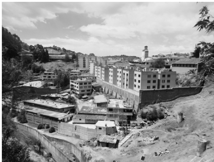
Zona residual sobre la quebrada Chimbacalle
