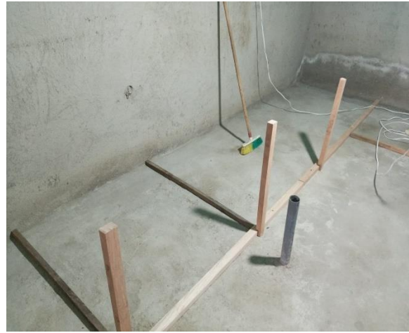
Figura 2. Construcción de las unidades experimentales
