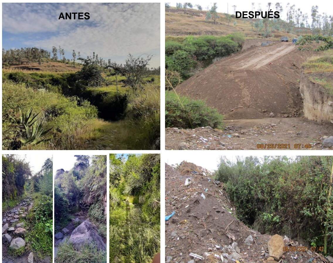
Ilustración 8: Collage que muestra el antes y después del relleno de quebradas e improvisación de caminos Fuente: Elaboración propia 2023.
