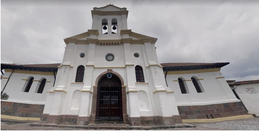
Foto N° 4 Fachada de la Iglesia central de Píntag.
