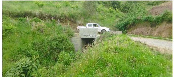
Vehículo de inventario sobre alcantarilla de gran tamaño
