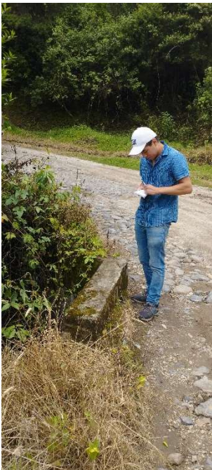
Alejandro Cadena registrando las coordenadas de alcantarilla
