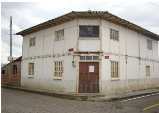
Imagen 3.11: Vivienda fachada externa
