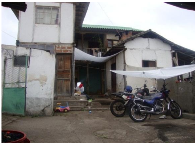
Imagen3.12: Vivienda fachada interna
