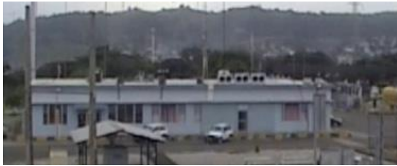
ILUSTRACIÓN 8 CASA DE CONTROL SUBESTACIÓN PASCUALES (GUAYAQUIL)
