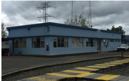
ILUSTRACIÓN 10 CASA DE CONTROL
