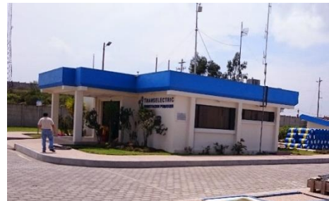
ILUSTRACIÓN 11 CASA DE CONTROL
