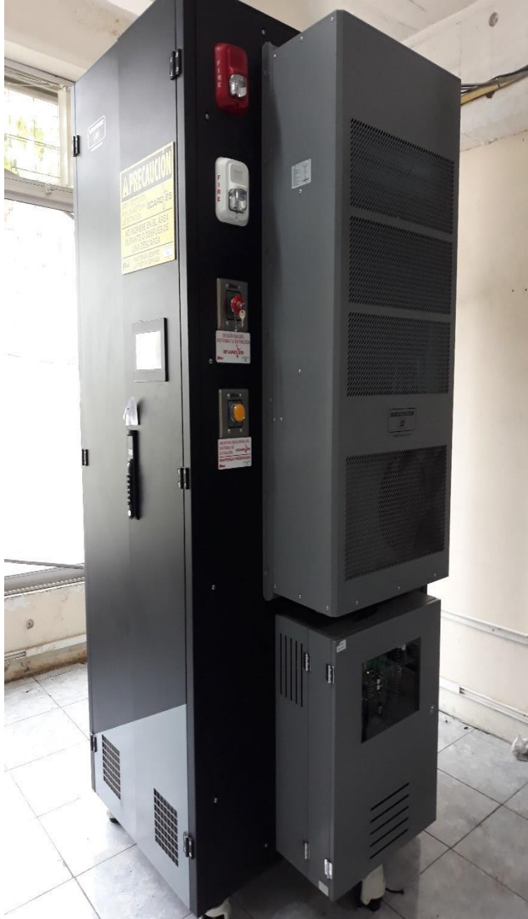
ANEXO 13 PARTE EXTERNA DEL DATA CENTER
