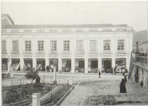
QUITO. Edificio de la Municipalidad.
