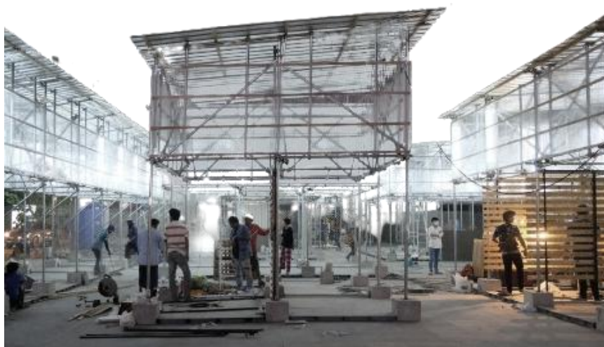
Figura 31: Fachada del módulo
