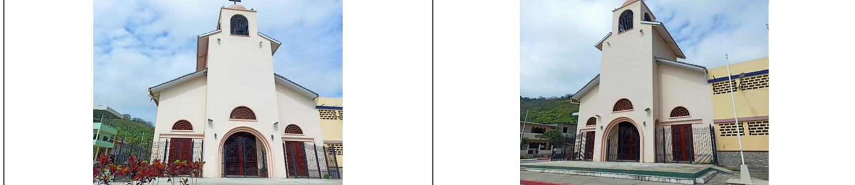
Fuente: Zona protegida La Tomatera
