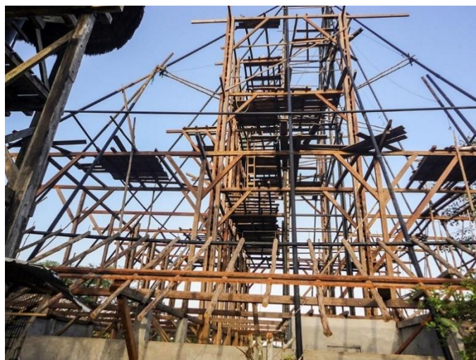
Imagen 38: Estructura de madera y tubos petroleros.
