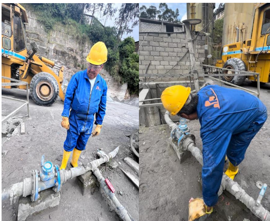
Imagen 3. Foto colocación del agua de mezcla
