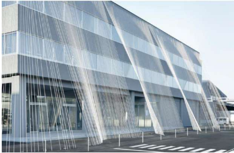
Figura 24. Edificación con material CABKOMA Fuente: Arcus Global (2022)
