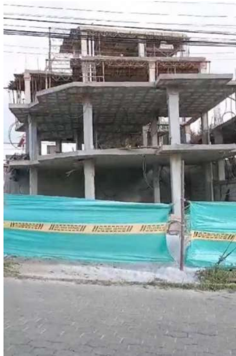
Figura 31: Obra gris de casa 1
