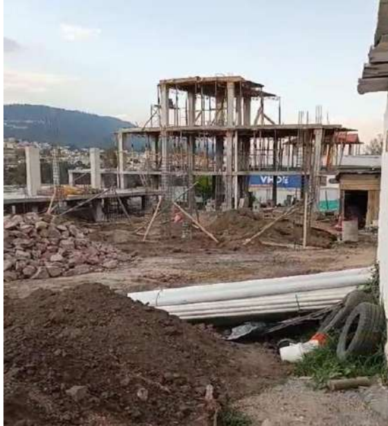
Figura 32. Obra gris de casa 2
