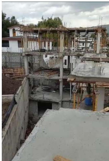
Figura 33. Obra gris de departamentos
