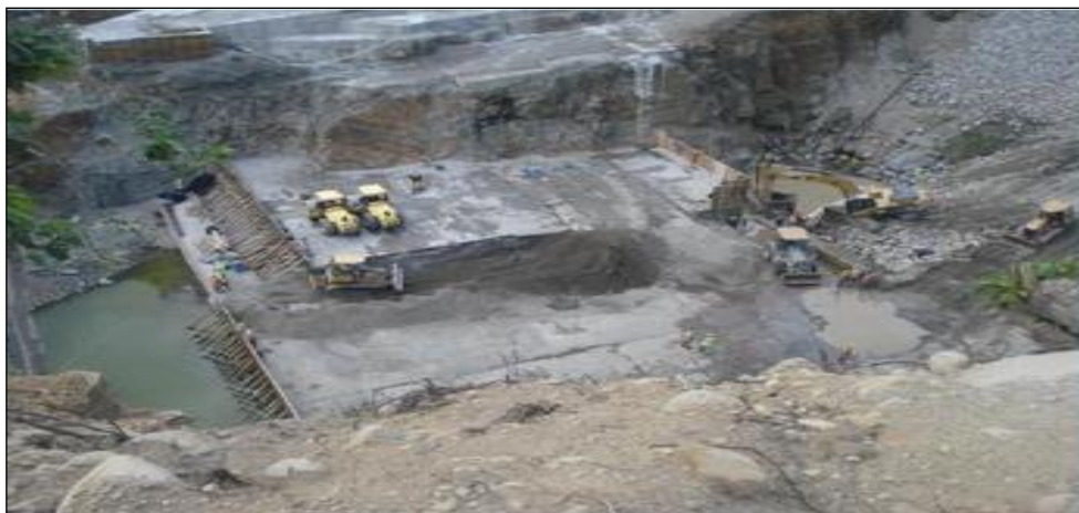
Figura 1.7 Construcción de represas - http://technoproject.com.mx/Site6.html
