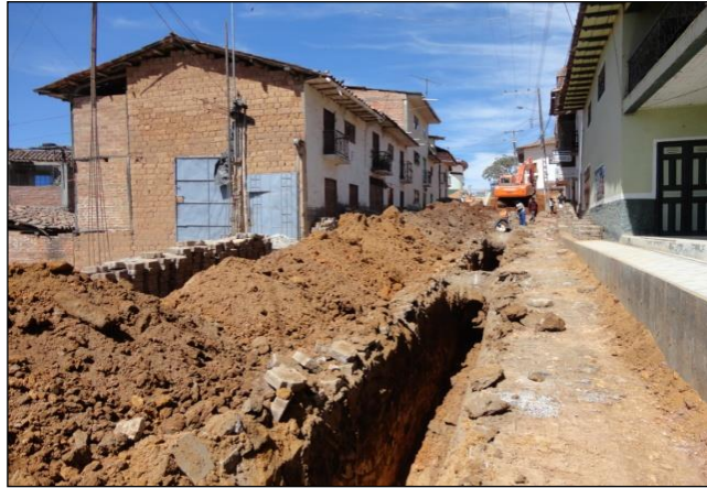
Figura 1.20 Archivo fotográfico Construcción de Alcantarillado en el Cantón Paltas Provincia de Loja. Autores: Ortega Gorki, Pacheco Maribel
