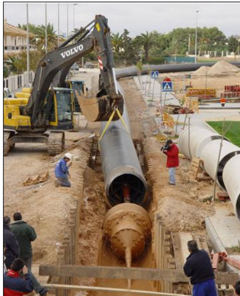
Figura 1.21 Colocación de tubería para alcantarillado - http://www.interempresas.net/ObrasPublicas/Articulos/39014-La-carta-de-la-ciudad-sin-zanjas.html
