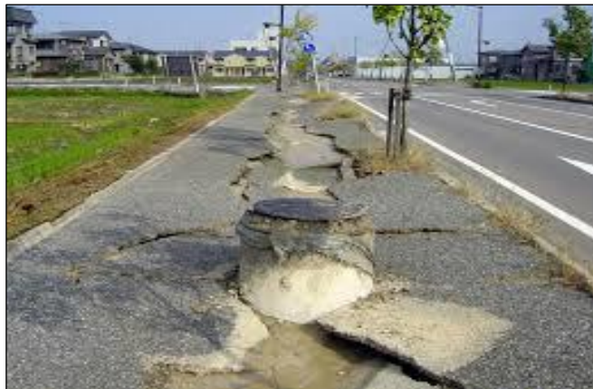
Figura 1.8 Licuefacción de suelos - http://imgres.upload.wikimedia.org/wikipedia .
