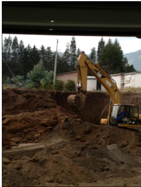
Figura 1.14 Maquinaria en desbanque bodegas del Banco del Pichincha sector Oyambarillo. Autores: Ortega Gorki, Pacheco Maribel
