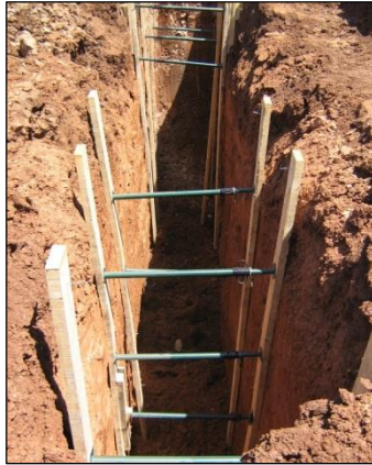
Figura 1.19 Entibación - http://www.cem-malaga.es/portalcem/novedade/docs/zanjas.pdf
