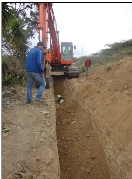
Figura 1.15 Archivo fotográfico Construcción de Alcantarillado en el Cantón Paltas Provincia de Loja. Autores: Ortega Gorki, Pacheco Maribel
