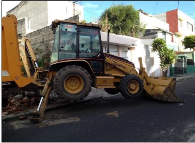
Figura 1.13 Derrocamiento Sector Antigo Aeropuerto. Autores: Ortega Gorki, Pacheco Maribel
