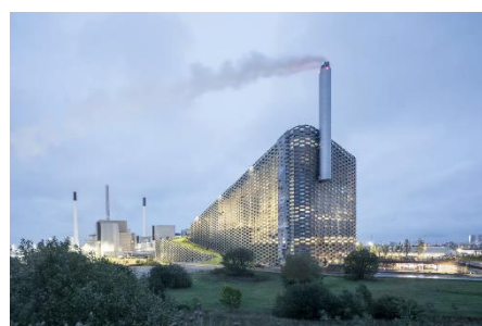
Figura 12 Planta de Energía - CopenHill. Elaborador por BIG. Fuente: BIG
