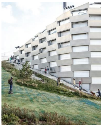
Figura 15 Planta de Energía - CopenHill. Elaborador por BIG. Fuente: BIG
