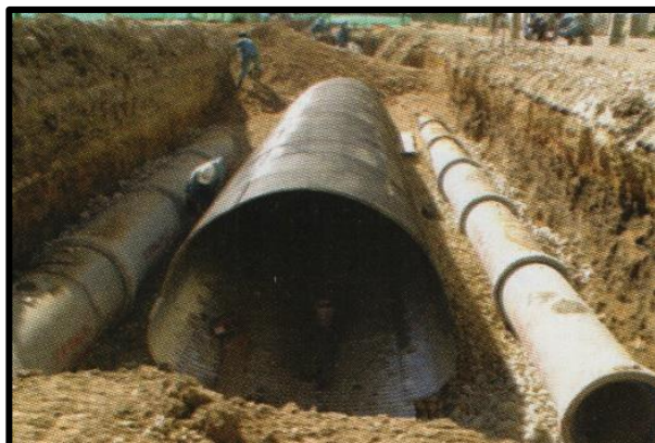
Imagen 4: Colector principal.
