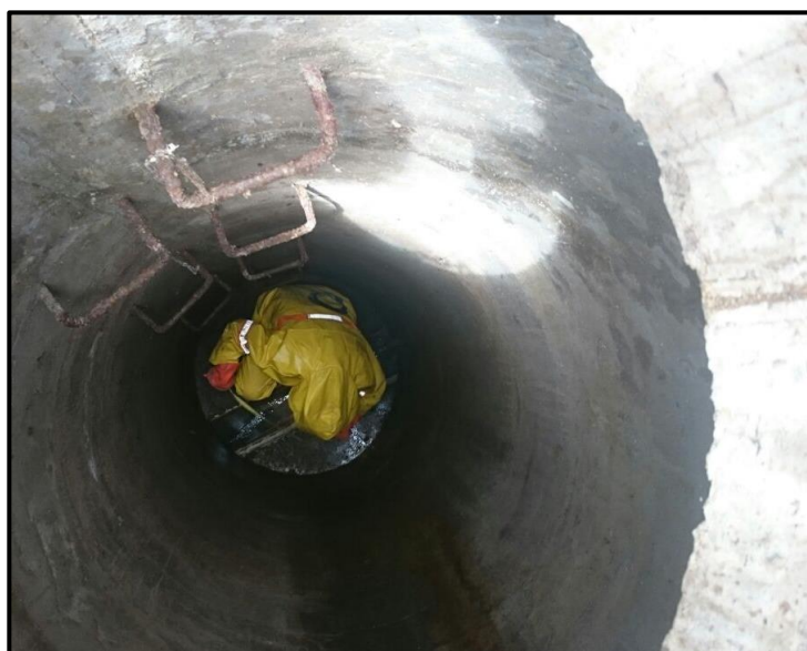
Imagen 24: Ingreso de personal a pozo de revisión.
