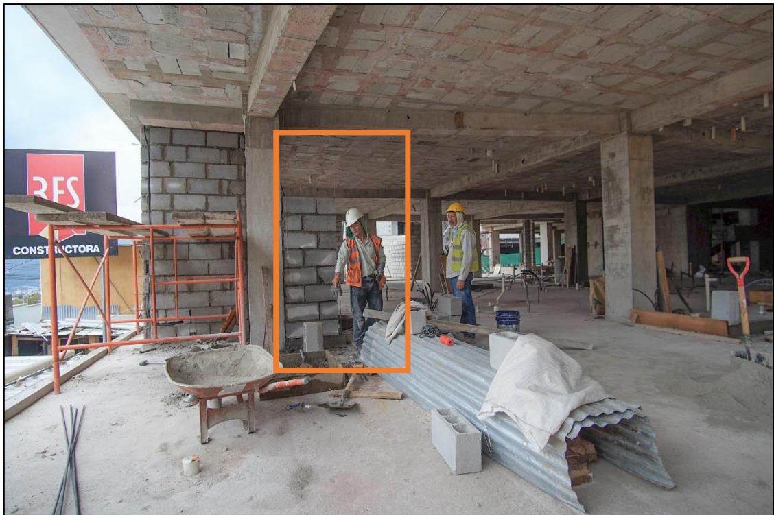
Figura 30. Fin de trabajos rubro mampostería de bloque Elaborado por: El autor
