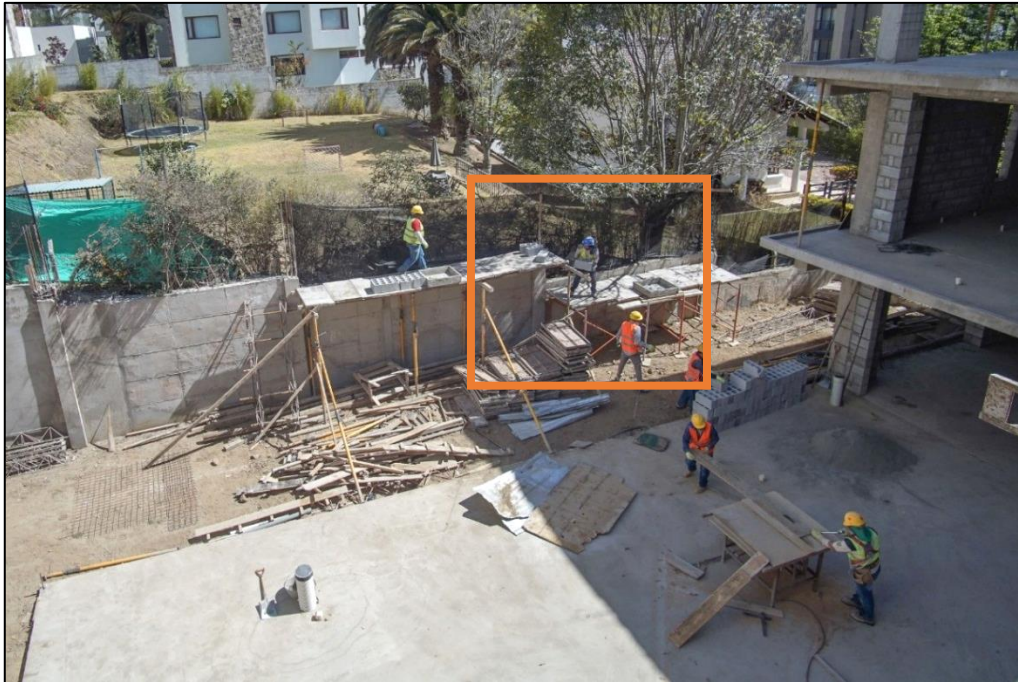
Figura 59. Inicio trabajos cerramiento de bloque
