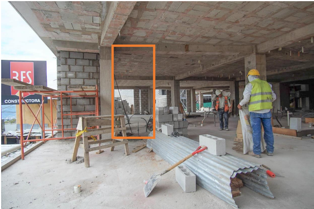
Figura 28. Inicio de trabajos rubro mampostería de bloque Elaborado por: El autor
