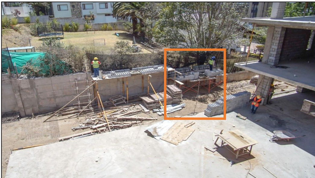
Figura 61. Fotografía final cerramiento de bloque
