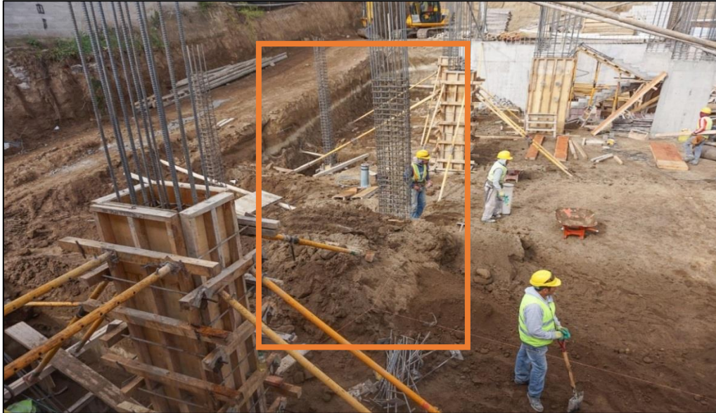
Figura 47. Inicio trabajos de encofrado de madera columna rectangular Elaborado por: El autor
