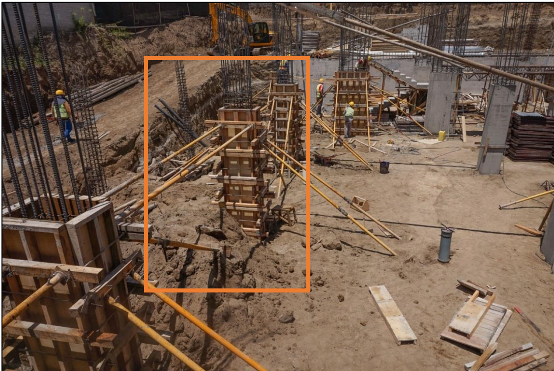
Figura 49. Fotografía final encofrado de madera columna rectangular Elaborado por: El autor
