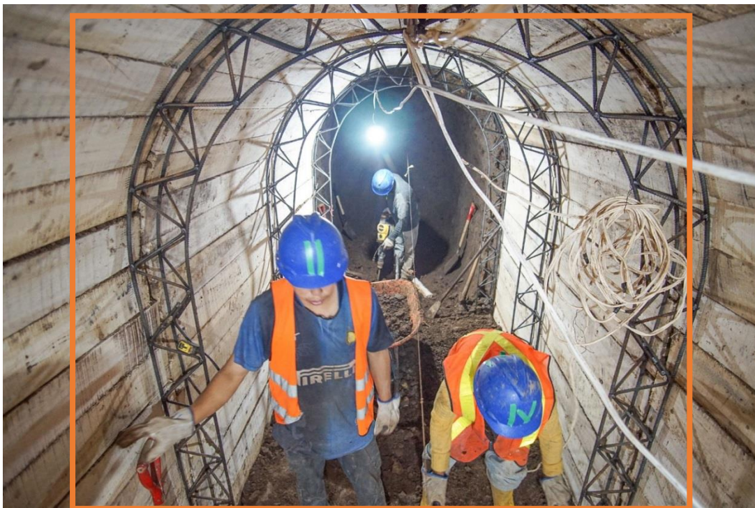
Figura 79. Fotografía final entibado y encofrado permanente de túnel
