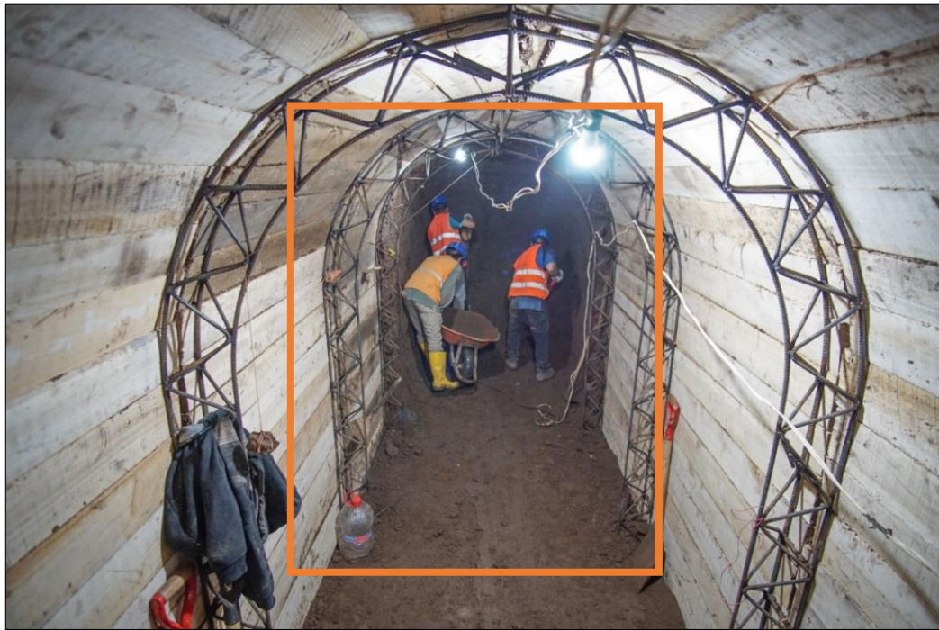
Figura 71. Inicio trabajos excavación túnel a mano en tierra.
