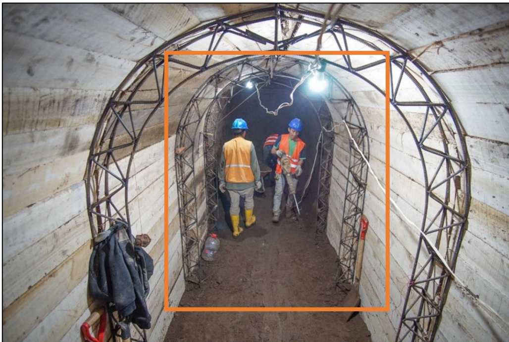
Figura 73. Fotografía final excavación túnel a mano en tierra Elaborado por: El autor
