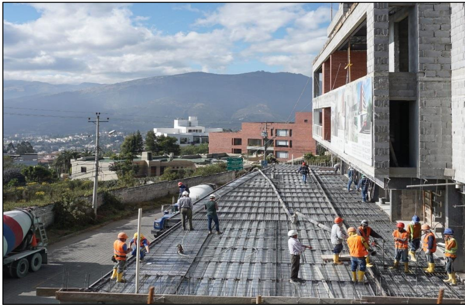
Figura 65. Inicio trabajos fundición losa colaborante Elaborado por: El autor
