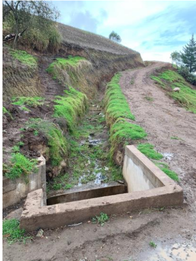
Ilustración 13. Vía con capa de rodadura tipo suelo natural
