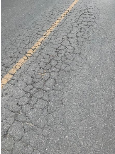
Ilustración 15. Fotografía con piel de cocodrilo
