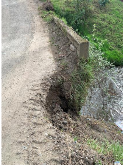
Ilustración 21. Fotografía con erosión fluvial
