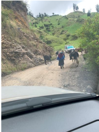
Ilustración 9. Fotografía de un camino con capa de rodadura tipo suelo natural
