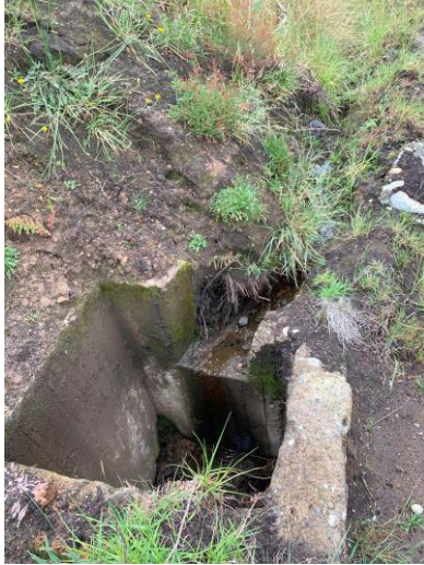
Ilustración 29. Fotografía con acumulación de lodo en la cuneta
