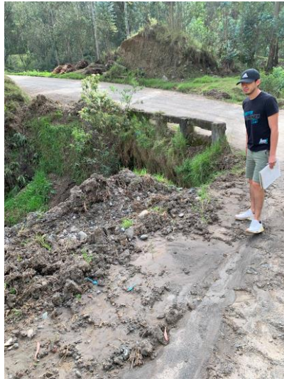
Ilustración 21. Fotografía con erosión fluvial
