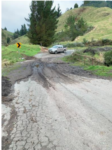
Ilustración 13. Vía con capa de rodadura tipo suelo natural
