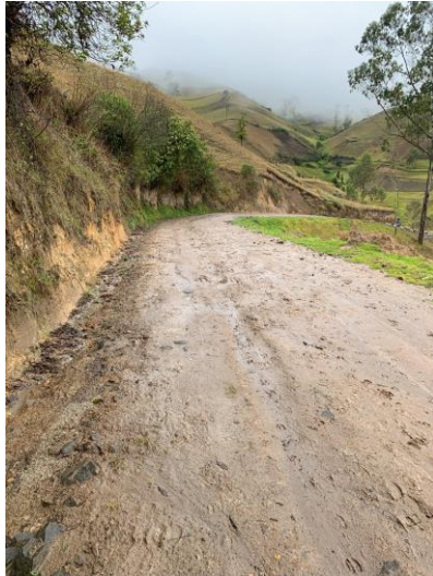
Ilustración 11. Fotografía de una vía resbalosa por el lodo generado por la temporada invernal
