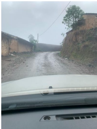
Ilustración 8. Fotografía de un camino con capa de rodadura tipo lastre
