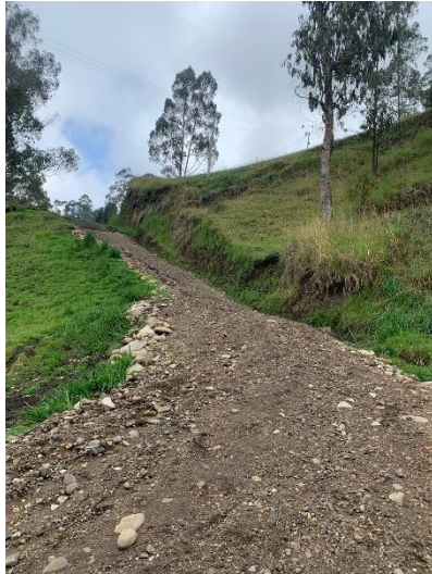
Ilustración 9. Fotografía de un camino con capa de rodadura tipo suelo natural
