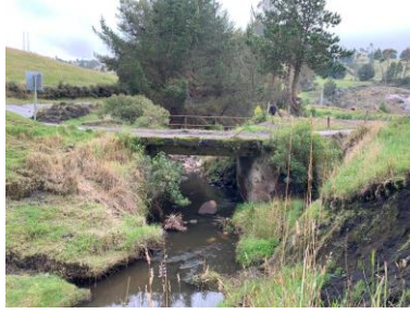
Ilustración 18. Fotografía de puente sin protecciones laterales
