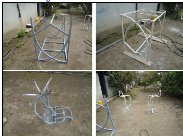
Fig. 5.29: Proceso de Acabado
