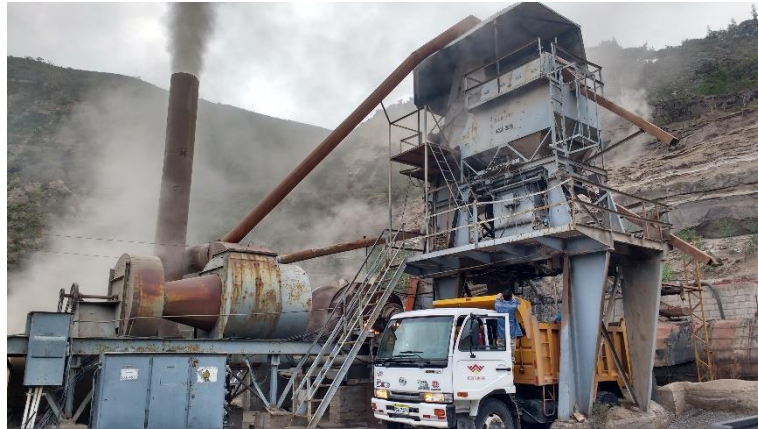
Figura 1.4: Planta asfáltica TEA S.A. (Balseca & Becerra, 2017)
