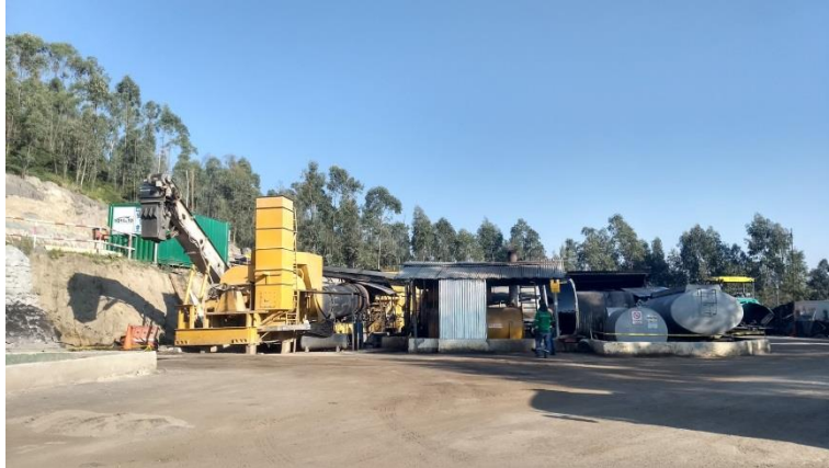
Figura 1.2: Planta asfáltica EQFALTO (Balseca & Becerra, 2017)
