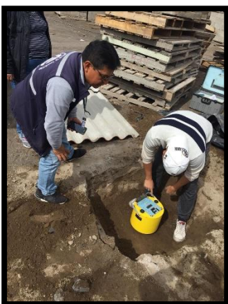
Fotografía 9.15 Ensayo del GeoGauge
