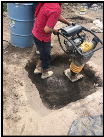
Fotografía 9.13 Compactación de la subrasante con vibro apisonador
