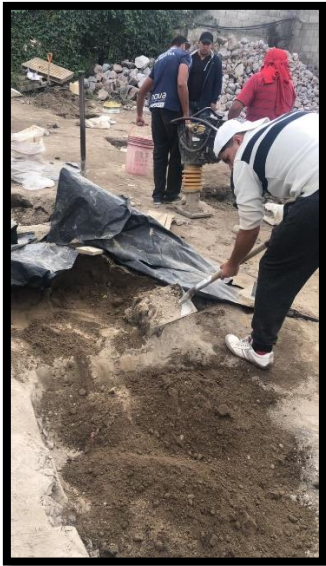
Fotografía 9.11 Excavación del cajón
