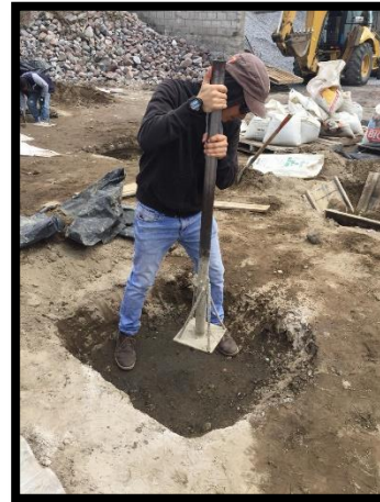
Fotografía 9.12 Compactación de la subrasante con apisonador manual
