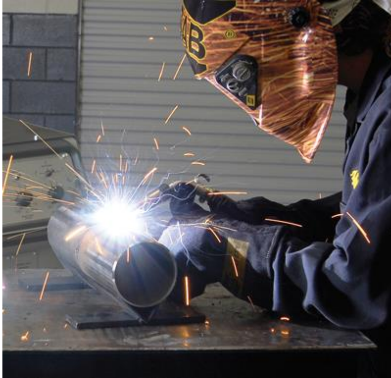
Figura 16.- Proceso de soldadura de láminas de acero
