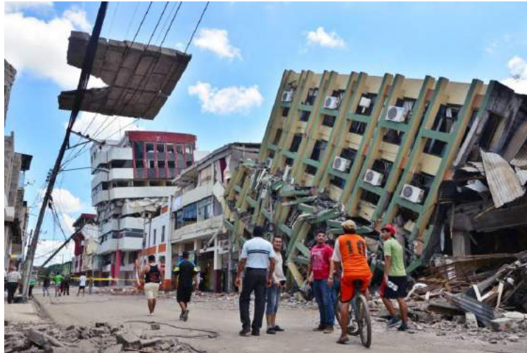
Imagen 1 Terremoto de la Zona Cero Fuente: Diario el Mundo 2016
