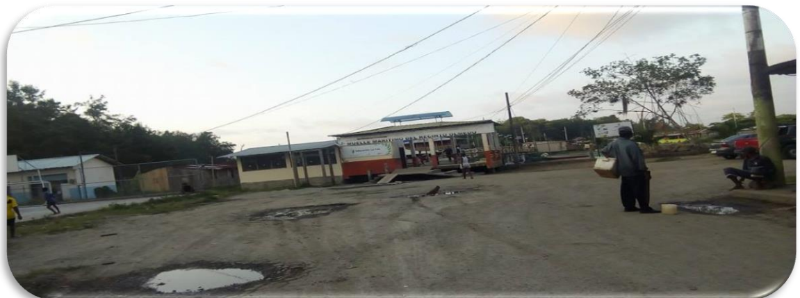
Estado de las calles y vías principales de La Tola
