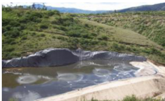
Foto 2 Piscinas de almacenamiento de lixiviados sin tratamiento.
