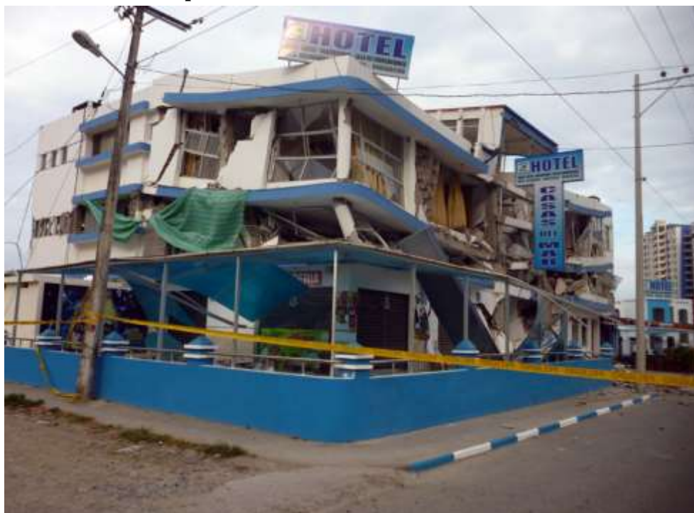
Fotos: Edificios caídos por el desastre natural
