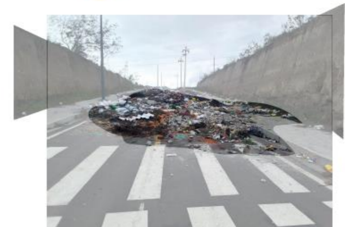
Contaminación en una de las calles colectoras del anillo vial.
